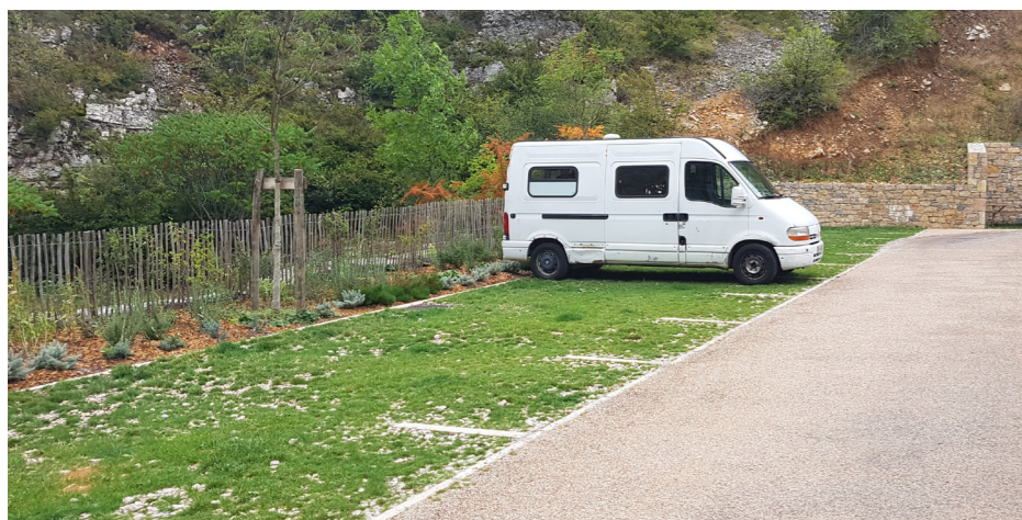
Stationnement perméable en terre pierre
