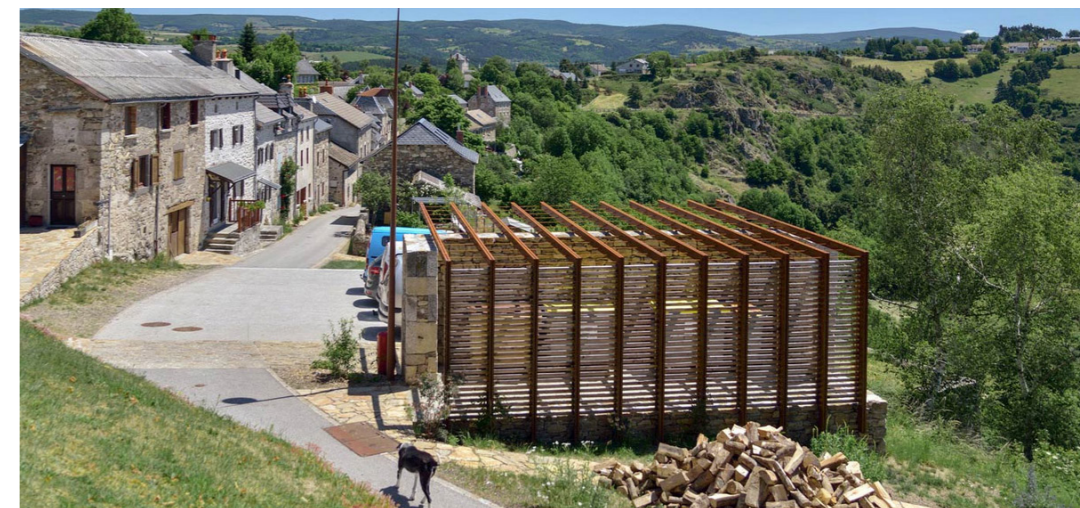
Abri à poubelles : murs en pierres locales et pergola/clastra - Chaliers (15) Simon Teyssou & Associés
