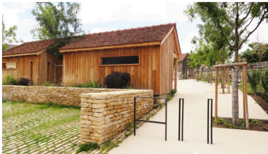
Dallage permettant un stationnement perméable, mur en pierre sèche, abris en bois et pieds d'arbres laissés libres
