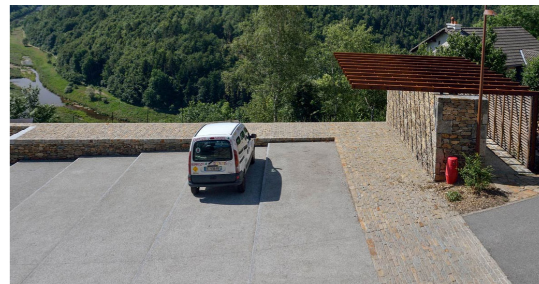
Différences de matériaux selon les usages : stationnement / cheminement - Chaliers (15) Simon Teyssou & Associés
