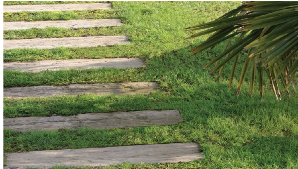
Cheminement avec des traverses en bois
