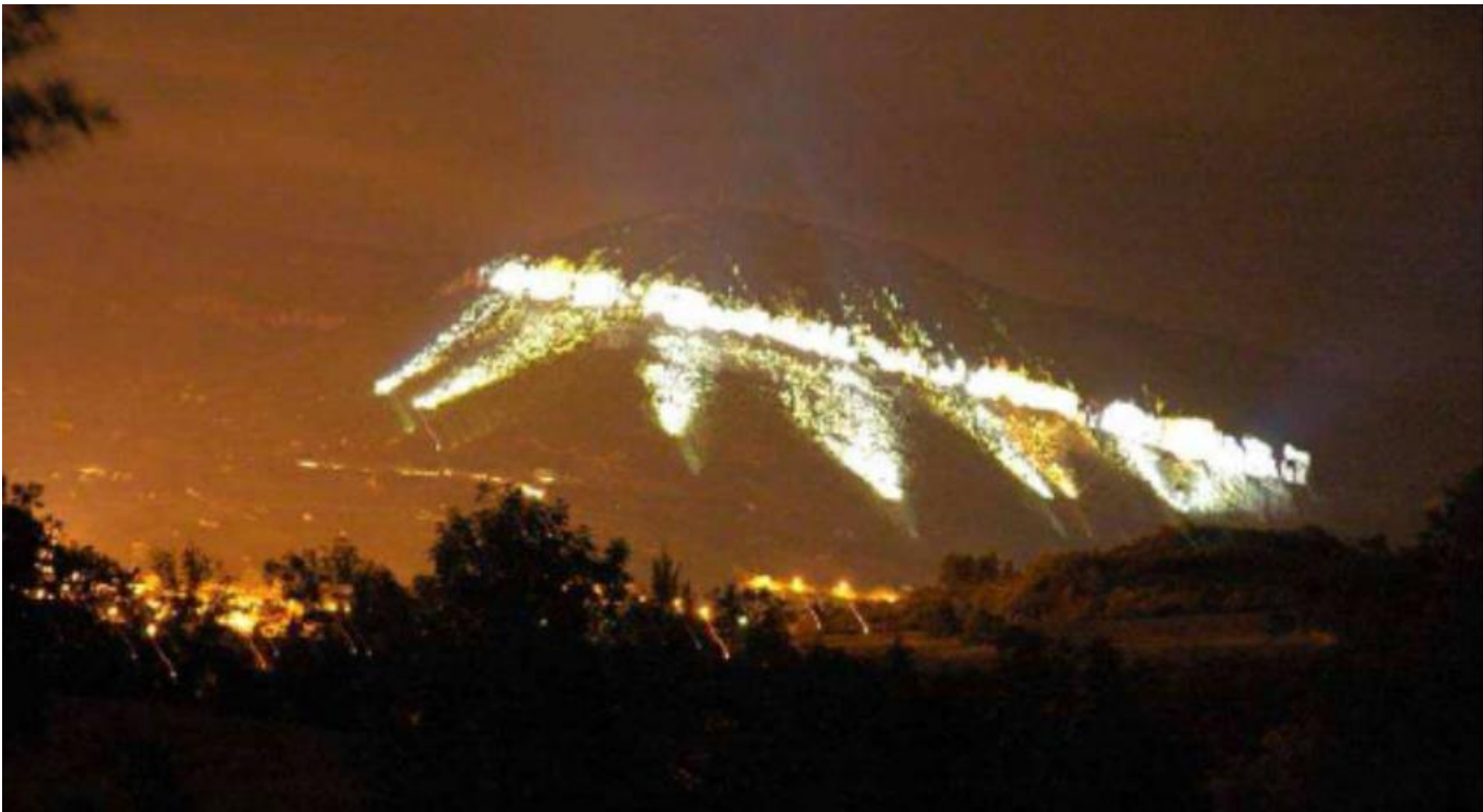
Falaises au dessus de Millau, avant dépose du système d'éclairage en 2020
