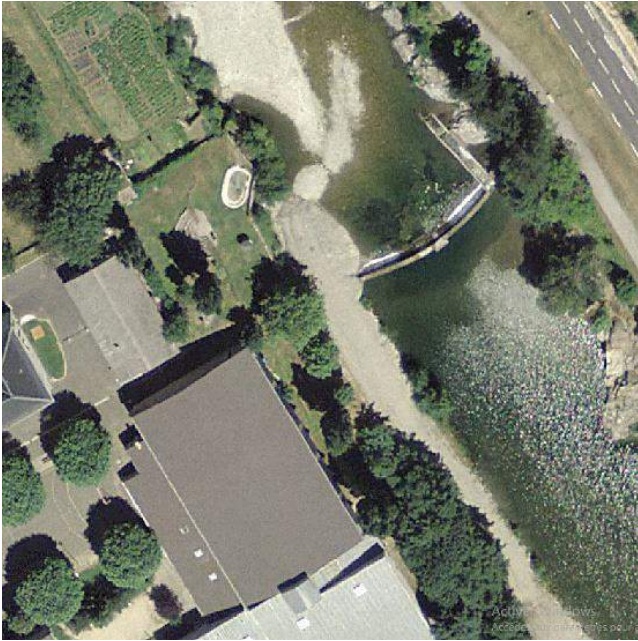
Seuil (et passe-ralentisseur) de Florac avant destruction
