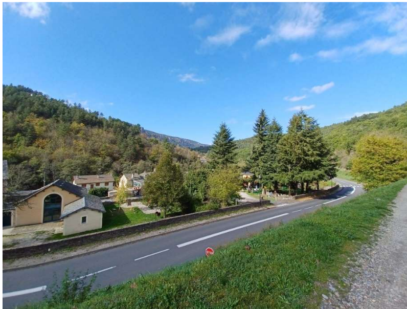
La RD106 au niveau de La Salle Prunet
